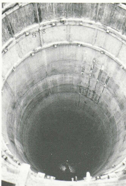
Fig. 3. — Intérieur en cours de bétonnage.
