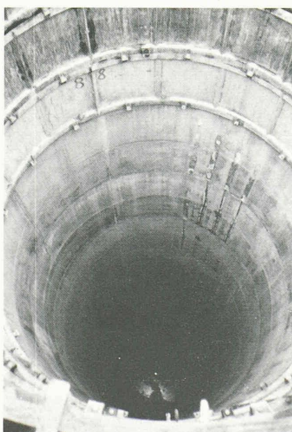
Fig. 3. — Intérieur en cours de bétonnage.
