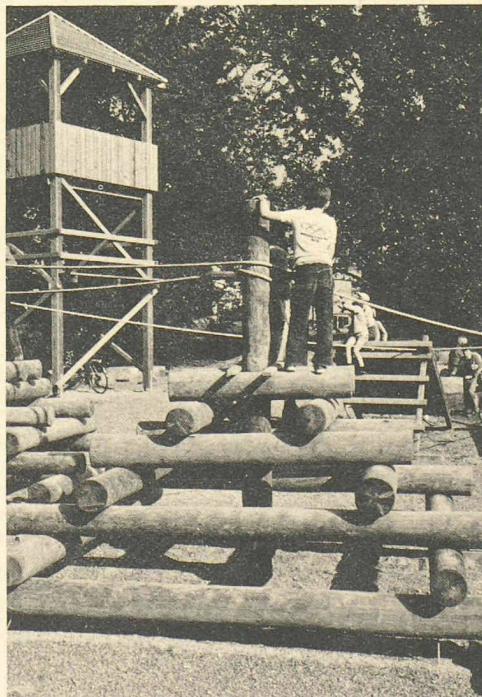
Fig. 3. — Pour prolonger la durée de vie de ces éléments de jeu en bois, il faut les imprégner soit par trempage soit sous pression, sans risque de toxicité pour les enfants.
