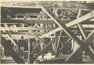
On est actuellement en train de démolir « en douceur » la plus grande tour de séchage encore debout en Suisse, propriété de Forbo-Ennenda SA. Le démontage se fait tuile par tuile, poutre par poutre, en numérotant chaque pièce séparément.
