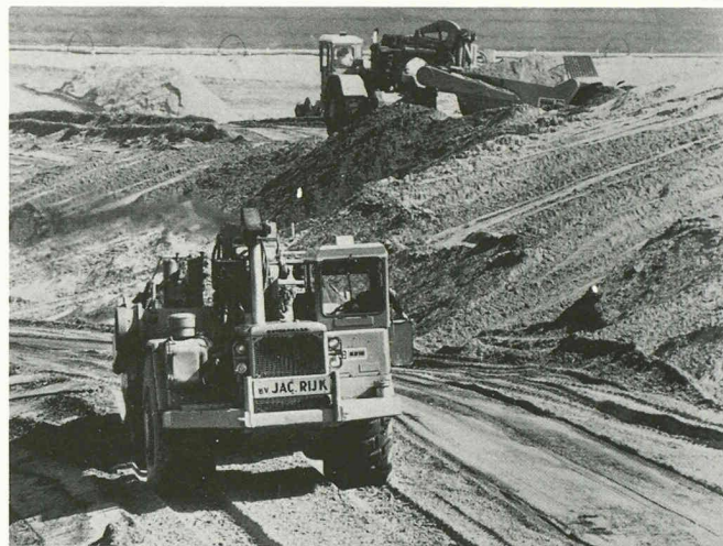
Scrapers automoteurs 631B Cat du parc de 20 machines Cat ayant participé au creusement des batardeaux pour la construction du barrage de l'Escaut oriental — un contrat qui nécessitait le déplacement de 2250 millions de m 3 de matériaux en quatorze mois.
