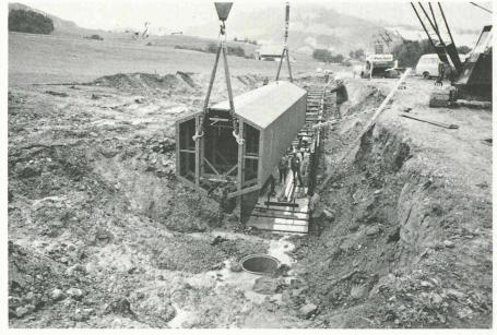
Fig. 4. – Déplacement du coffrage intérieur.
