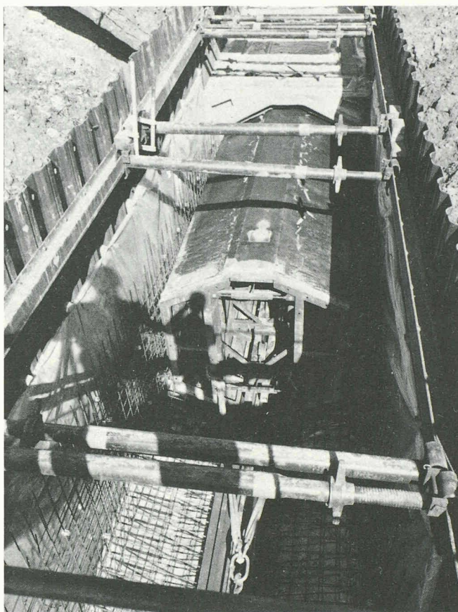
Fig. 2. — Collecteur en cours de bétonnage.
