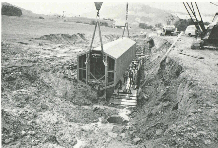
Fig. 4. — Déplacement du coffrage intérieur.
