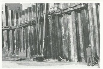
Fig. 3 - Détail d'ancrage des palplanches.
