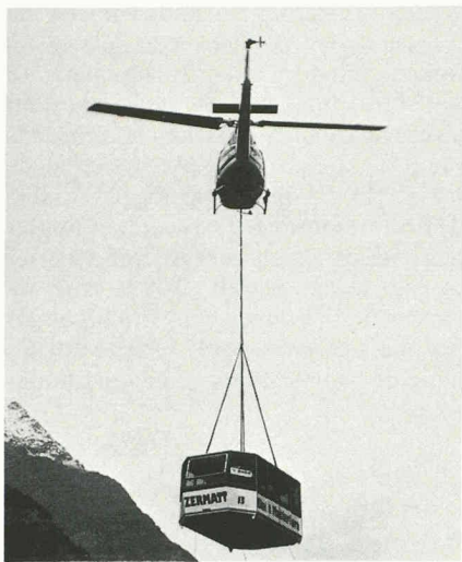
Recours à l'hélicoptère (1979) alors le plus puissant de Suisse (Bell 214 d'Héliswiss, à Berne) pour amener de Täsch à Trockener Steg une des deux cabines de 100 places du Petit-Cervin: 1965 kg!
