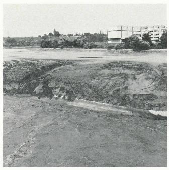
Fig. 10. — Protection en rive gauche visible pour la première fois depuis 1945, du fait de l'élimination des dépôts.
