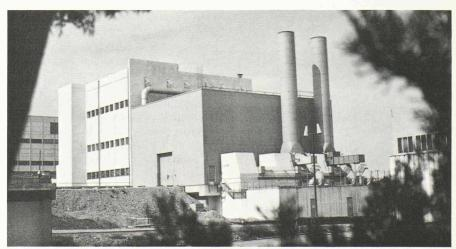
L'atelier de vitrification des produits de fission à Marcoule. Capacité de traitement : 200 conteneurs par an ; capacité de stockage : 380 m³ dans 220 puits de 10 m de profondeur.
