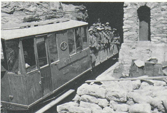
Fig. 21. — Les mineurs allant travailler au tunnel de l'Eiger (1908).
