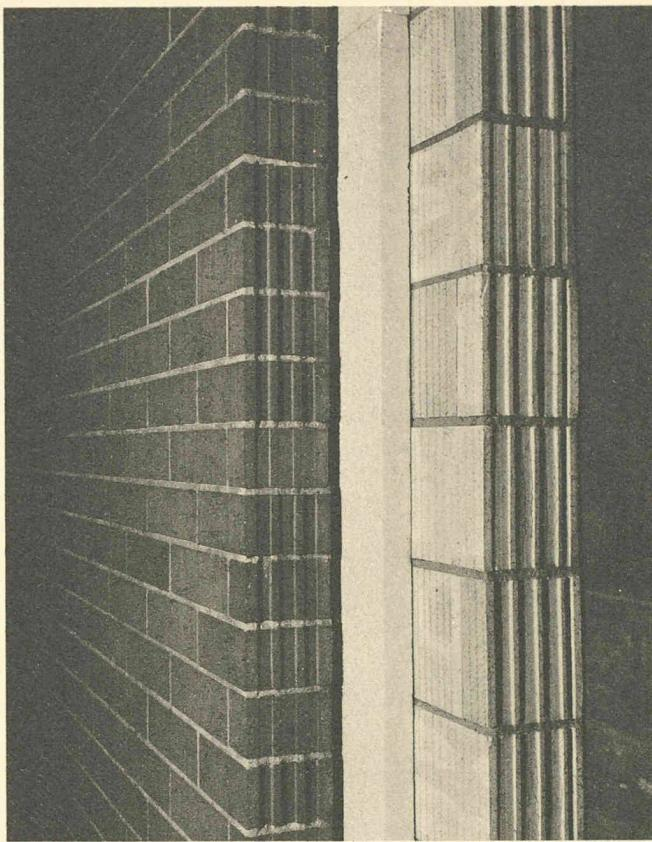
Le mur à double paroi nécessite des soins attentifs contre les influences extérieures ainsi qu'un traitement de l'appui des dalles en façade (en ce qui concerne aussi bien les fissures que les ponts thermiques); mais il présente une inertie thermique certaine, garantie d'un confort accru.
