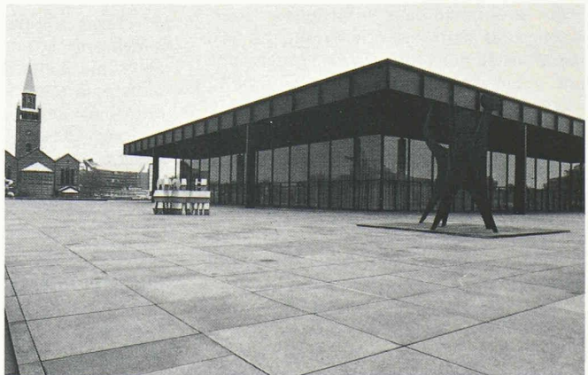
Neue Nationalgalerie, 1962-1963. Ludwig Mies van der Rohe, architecte. A gauche, la Mathäuskirche.
