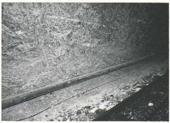
Fig. 5. - Cette conduite suspendue dans le tunnel du chemin de fer sert à conduire les eaux usées du restaurant à la STEP de Grindelwald.
