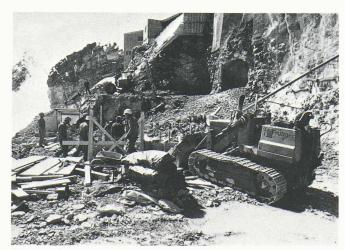
Fig. 4. – Il a d'abord fallu créer une plate-forme où puissent évoluer les machines de chantier.
