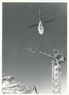
Fig. 10. — Pour le montage des grues de chantier, il a été nécessaire de recourir à l'hélicoptère.
