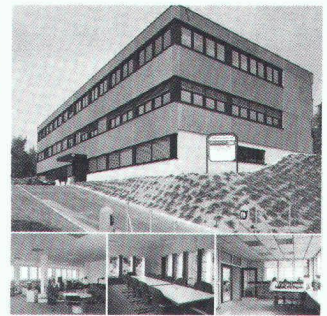
Bâtiment industriel et administratif Techno-Lens 1052 Le Mont-sur-Lausanne
