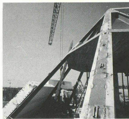
Fig. 7. — Montage d'une colonne.
