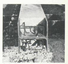
Fig. 3. – Elément porteur visible avant l'aménagement intérieur.
