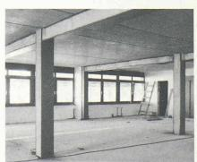
Fig. 4. - Assemblage colonne - sous-poutres.
