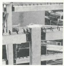
Fig. 2. – Elément de colonne en construction mixte.
