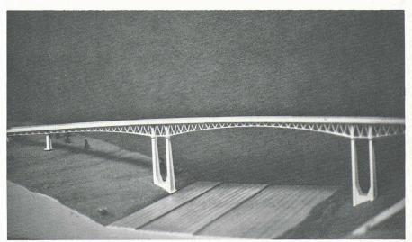
Fig. 11. - Projet de pont à treillis en béton.
