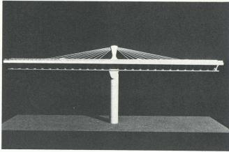
Fig. 22. - Maquette du viaduc de l'Arrêt-Darré (projet SECOA).
