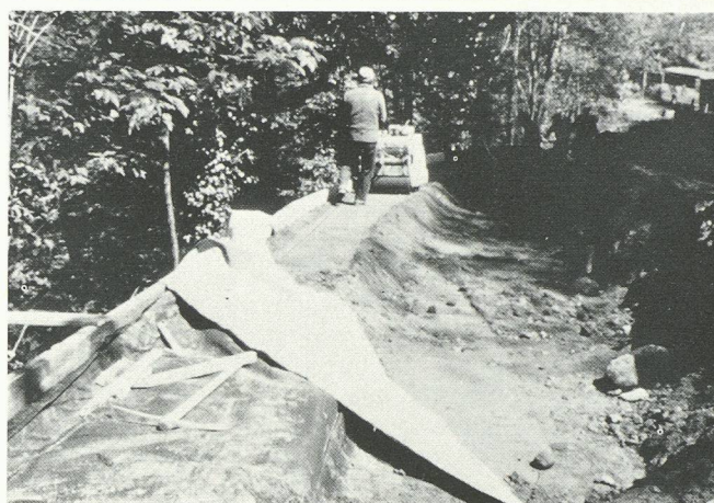
Fig. 9. — Opération de compactage.
