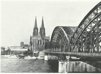
Au premier plan, le pont ferroviaire (à quatre voies) et routier de Hohenzollern, construit de 1907 à 1911 et reconstruit après sa destruction en 1945. Plus de 1000 trains l'empruntent quotidiennement; aujourd'hui, la traction électrique a éliminé les locomotives à vapeur et diesel, alors que la navigation rhénane recourt encore aux combustibles fossiles.
