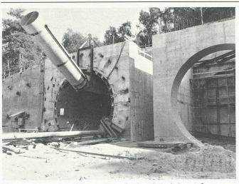
Tête sud du tunnel de Villejust. A gauche, la galerie de la voie 2, en cours d'excavation. A droite, l'ouvrage destiné à servir d'appui au tunnelier de 9,25 m de diamètre qui attaquera la voie 1.
