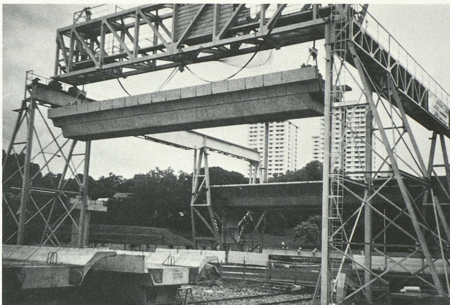
Fig. 17. — MRT Singapour ; levage d'une poutre à caisson préfabriquée en béton précontraint, d'une masse de 165 t.
