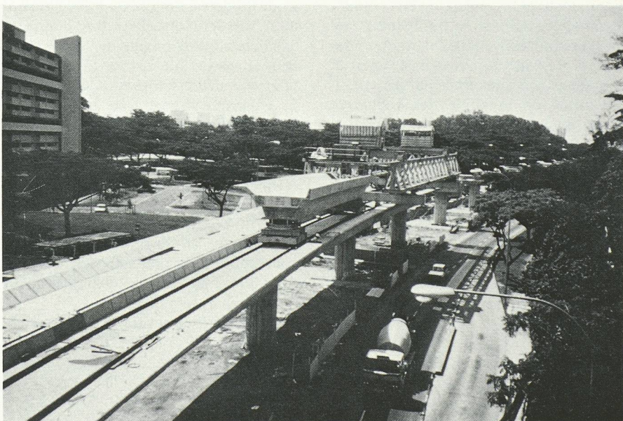
Fig. 18. — MRT Singapour ; transport d'une poutre préfabriquée sur la partie construite du pont jusqu'à l'installation de mise en place.
