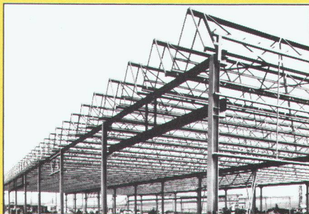
Structure métallique d'une usine – toiture mini-shed –
