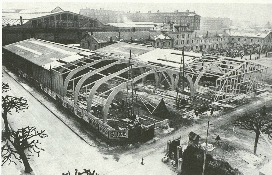
Un témoignage de savoir-faire se déplace: la halle du Palais des Expositions de Genève, construite en 1955 (photo) a quitté cet emplacement en 1985 pour reconstruction à la campagne.
