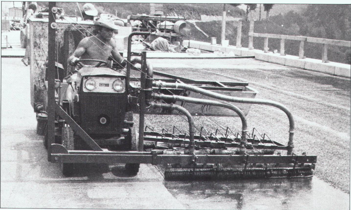
Un système amélioré d'étanchéité élastique, ne contenant pas de solvants volatils, permettant de « ponter » les fissures de béton.
