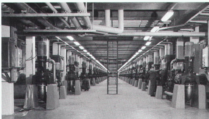
Installation d'épuration Lynetten, Copenhague, 115 pompes TURO.
