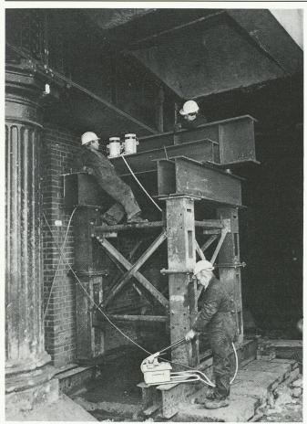
La mise en place des tréteaux a nécessite le soutenement temporaire des fondations en béton armé au moyen de profilés en acier à haute résistance ainsi que de vérins de levage et de pompes à main hydrauliques Enernac.
