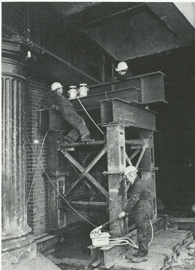
La mise en place des tréteaux a nécessité le soutien temporaire des fondations en béton armé au moyen de profilés en acier à haute résistance ainsi que de vérins de levage et de pompes à main hydrauliques Enerpac.
