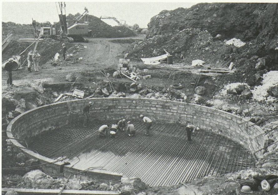
Fig. 12. - Fondation d'une pile en mer.
