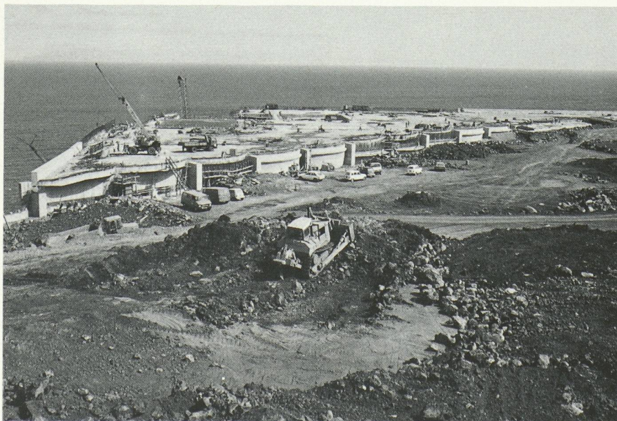
Fig. 17. — La plate-forme triangulaire en cours de finition et avant la fin du remblayage. On voit encore le mur de soutènement avec ses voûtes verticales.
