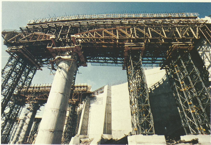
Fig. 14. — Le système d'échafaudage utilisé pour la réalisation des sommiers sur les piles ne dépassant pas 30 m.
