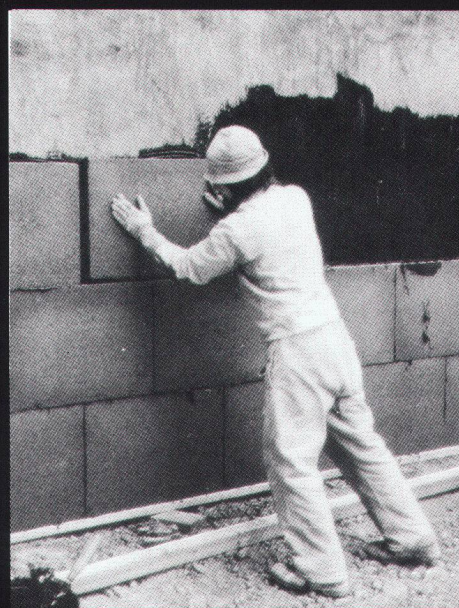
Mur contre terre : Isolation périmétrique avec FOAMGLAS-BOARD ou FOAMGLAS T2 collé à pleine adhérence et à joints remplis au moyen de colle bitumineuse à froid.
