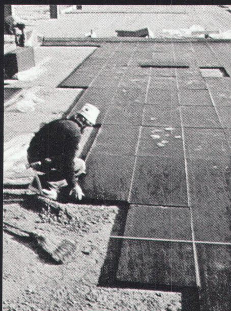
Isolation de sol sous radier/dallage : Pose à sec sur couche d'égalisation de panneaux FOAMGLAS-BOARD, revêtus en usine et sur les deux faces de papier bitumé.
