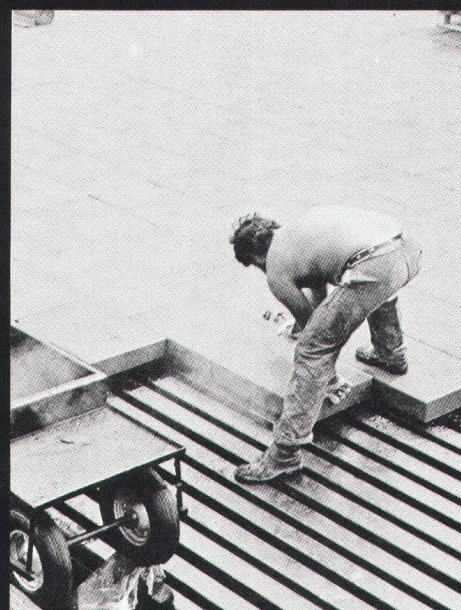
Toiture plate sur tôles profilées : Système « Toiture compacte », avec FOAMGLAS T2 collé directement sur les tôles après trempage des plaques dans un bac à bitume chaud
