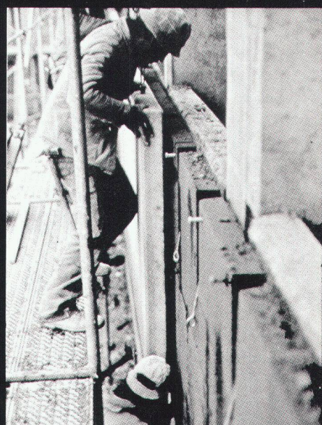
Façade ventilée avec revêtement en éléments lourds posés à joints ouverts : FOAMGLAS T2 collé à pleine adhérence et à joints remplis au moyen de colle bitumineuse à froid.
