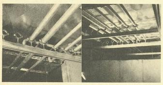
Le système de rails Unistrut de Hilti offre une grande flexibilité grâce à des rails standards et des pièces de jonction standards, en outre de rentabilité à outrance pour l'installation.
