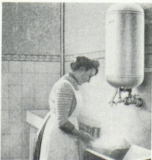
Chauffe-eau électrique mural dans une ancienne cuisine.
