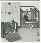
Installation d'un chauffe-eau dans un placard-socle de montage regroupant les distributions d'eau froide et chaude.
