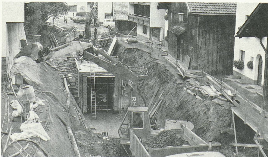
Le centre du village pendant la construction de la galerie à ciel ouvert. Il a fallu également déplacer les canalisations existantes.
