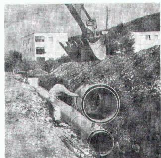
Les tuyaux Armaveron/Hobas à double fourreau; le meilleur système de conduite d'eau usée dans les zones de protection des eaux souterraines.
