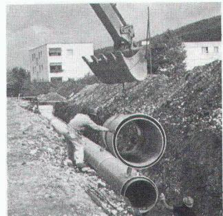
Les tuyaux Armaveron/Hobas à double fourreau; le meilleur système de conduite d'eau usée dans les zones de protection des eaux souterraines.
