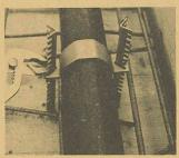
térieur les cames supérieures. Cette fixation est tellement stable que tous autres travaux, comme par exemple le placement de barres d'armature et le tassement par vibration du béton, peuvent être faits sans problèmes.
