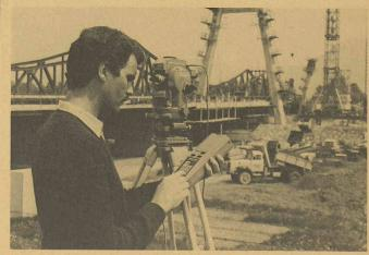
L'emploi du terminal de données GRE3 Wild se fait conjointement aux instruments de géodésie opto-mécaniques (théodolites, niveaux, lunettes zénith-nadir) pour l'introduction manuelle des données, mais aussi conjointement aux instruments électroniques pour enregistrement automatique des données.
