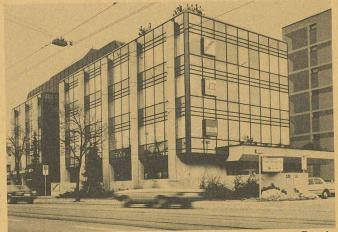
Immeuble commercial «Letziguet» à Zurich. Construction: Façaderideau calorifugée en aluminium réalisée avec le système de construction métallique AS-200.
