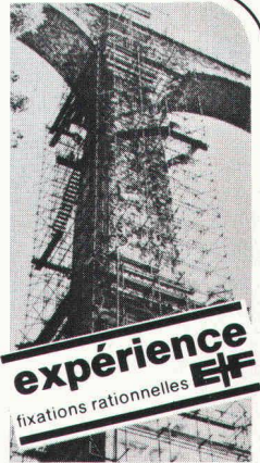
Fixation d'un coffrage
