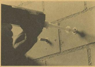
Scellement rapide grâce à la technique d'injection HIT de Hilti : le mortier est pressé dans le tamis et la tige d'ancrage est enfoncée. Après la durée de durcissement (variant de trente minutes à trois heures, selon la température extérieure), la tige d'ancrage peut être soumise à une charge.
