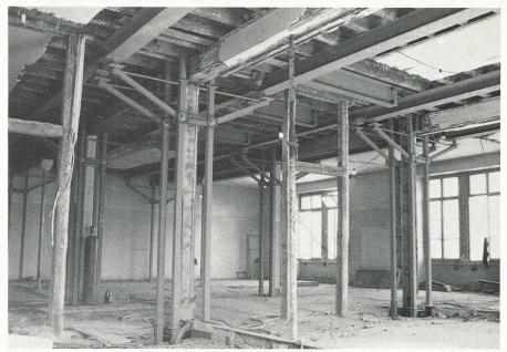
Fig. 2. — La structure nouvelle se superpose à la structure existante.
