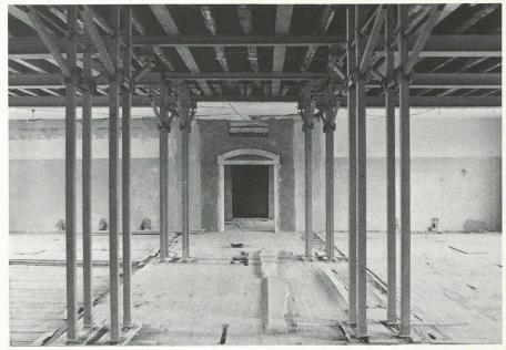
Fig. 8. - Le nouveau dispositif structurel avec maintien des anciennes poutres.
