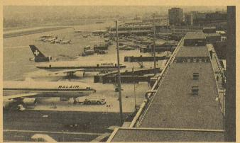
13 000 m² de Sopravap protégent l'isolation thermique de 10 cm d'épaisseur des toits plats du terminal A à docks multiples et de la tour de contrôle de l'aéroport de Zurich.
