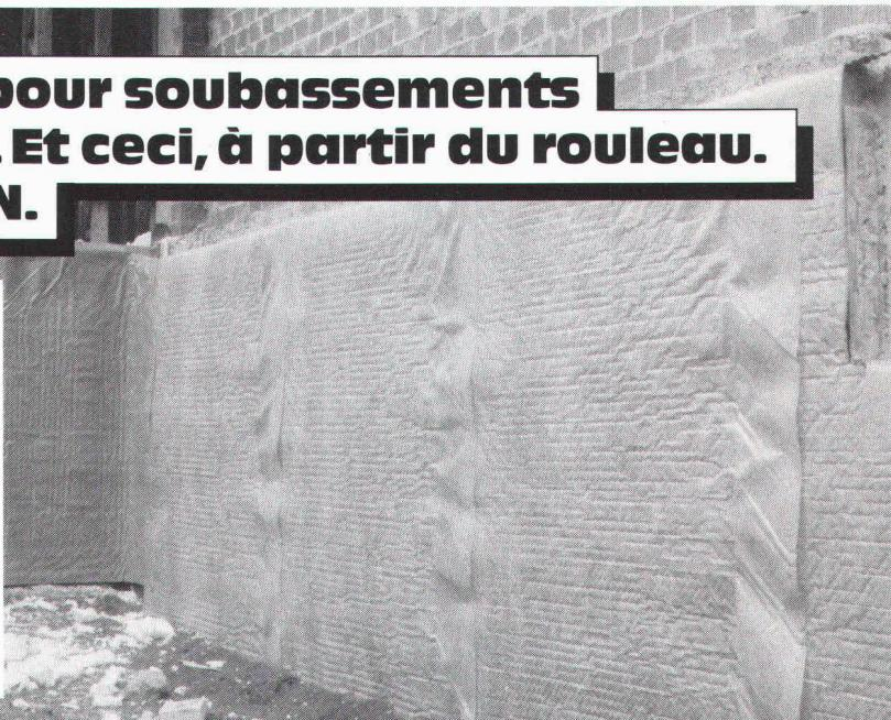
DELTA-MS-DRAIN: la protection pour soubassements, à deux couches. Couche 1: le non-tissé filtrant stable et résistant à la compression. Couche 2: la bande à excroissances en polyolé-
