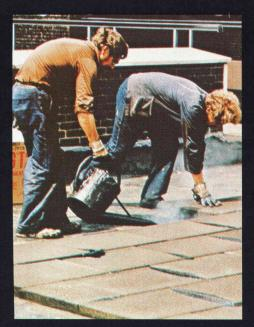
Toiture plate sur dalle en béton: Système «Toiture compacte», avec FOAMGLAS T2 collé à pleine adhérence et à joints remplis au bitume chaud.
