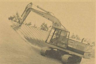
Pour planer 30 000 m² sur la piste d'essai Volkswagen en l'espace de 4 semaines, l'entrepreneur a monté des planeuses FF-Blitz Eurobauma sur trois pelles hydrauliques 215 Cat.
