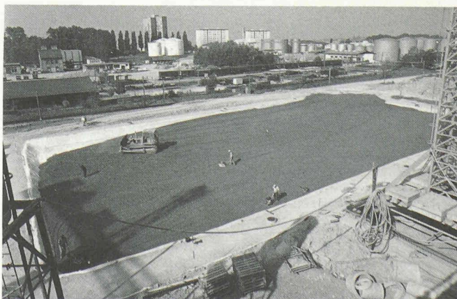
Fig. 12. — Vue générale d'une piste extérieure: répartition du LECA.
