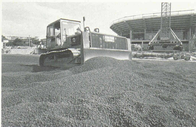
Fig. 11. — Mise en place du LECA.
