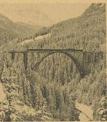
L'étanchéité exécutée par AEZ en 1912 avec un procédé encore valable de nos jours a impeccablement protégé la construction portante et donc le béton du viaduc de Langwies. Jusqu'ici, cet important ouvrage des Chemins de fer rhétiques n'a encore jamais dû être assaini. (Photo: AEZ Zurich/L. Gensetter, Davos.)
