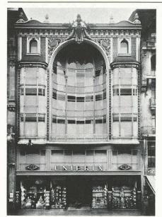
Fig. 5. — Vue en octobre 1930, à l'installation des grands magasins Uniprix. Les vitrages en façade ont été occultés et un mur a été construit en retrait; l'espace compris entre la nouvelle surface de vente, éclairée artificiellement et la façade, sert désormais de dépôt. Le rez-dechaussée a été transformé.
