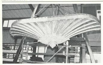
Fig. 14. - Base d'un bow-window en cours de montage.
