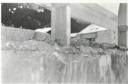
Désagrégation du béton d'une bordure de pont.
