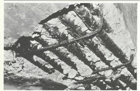
Corrosion prononcée de l'armature d'une poutre.
