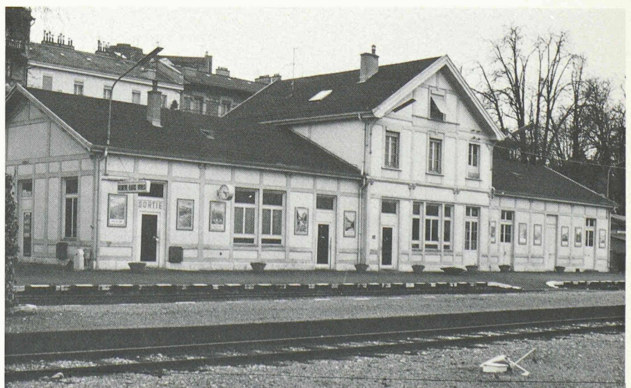
Le bâtiment de la gare de Genève-Eaux-Vives date de l'ouverture de la ligne en 1888. Il fut modernisé à l'intérieur en 1963 et un ravalement des façades eut lieu quelques années plus tard. Vue prise en décembre 1980. (Photo R. Kallmann.)
