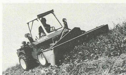
1975 Terratrak TT77 Mäher und Hanggeräteträger für Gelände bis 70% Neigung, Motor neben Lenker, extrem niedriger Bodendruck: Silbermedaille SIMA, Paris (Foto)
