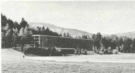
Polyvalente Grosssporthalle 44x84 m, Höhe 11 m, mobil einbaubare Rundbahn, mit 50 m freier Spannweite, vormals grösste Halle dieser Art
