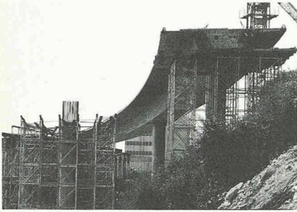
kasten in teilweise vorgespanntem Stahlbeton, vorgefertigte Betonbretter für Schalung der Fahrbahnplatte
