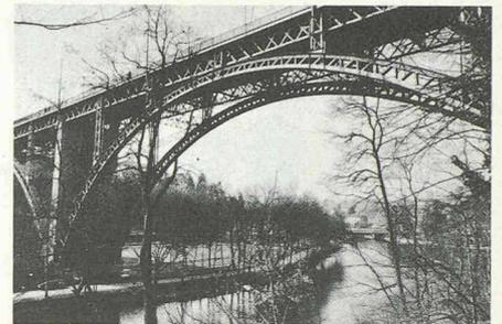
Une des œuvres maitresses de la construction en fer en Suisse; 2 travées d'une portée de 81 m, supportant des arcs en treillis sur lesquels s'appuie le tablier par l'intermédiaire de piliers en treillis
