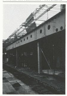
Fig. 14. – Poutres jumelées HEB 1000 en Fe 510.
